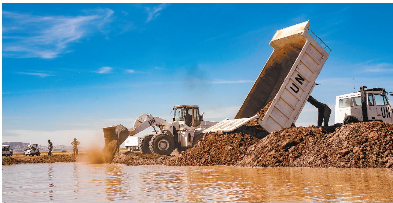
当地时间12月6日,中国第15批赴苏丹达尔富尔维和工兵分队外出施工分队,连续奋战72天,高效完成了联合国和非洲联盟驻达尔富尔联合特派团首批3个营地清理整治施工保障任务。图为分队官兵在回填积水坑。本报特约记者 熊家磊摄
