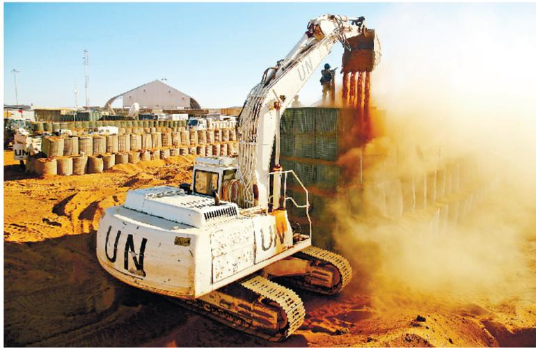
当地时间12月23日,我第7批赴马里维和工兵分队建成加奥机场入口防御哨塔。图为中国维和官兵利用履带挖掘机装填用于构建防御哨塔的沙箱。 本报特约记者 高嵩摄
