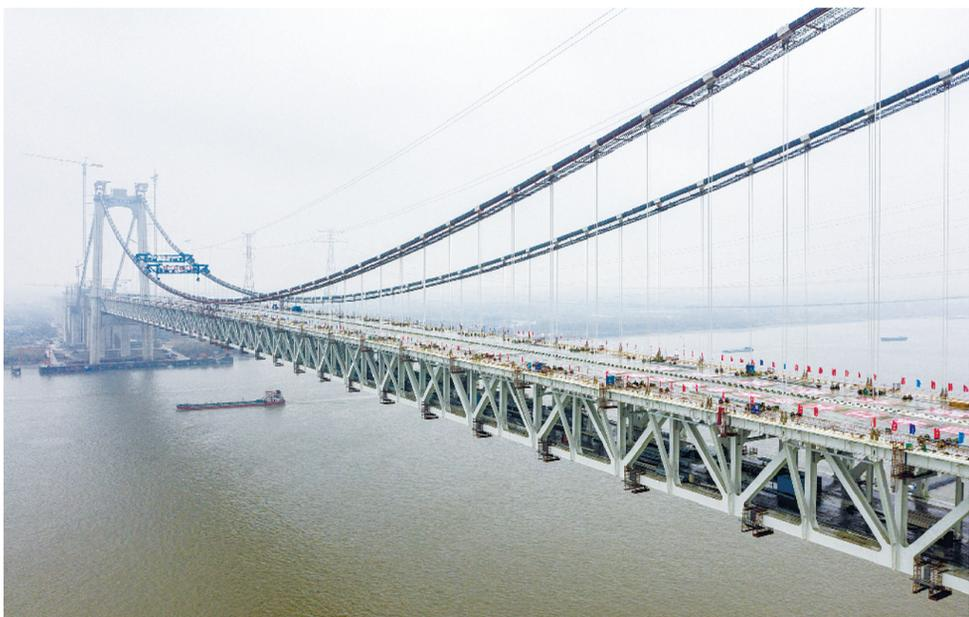
12月26日，我国首座公铁两用悬索桥五峰山长江大桥完成最后两节钢梁焊接，成功实现主桥合龙，该桥是世界上首座千米级高铁悬索桥。五峰山长江大桥连接江苏扬州市与镇江市，是连云港—镇江高速铁路的过江通道。
