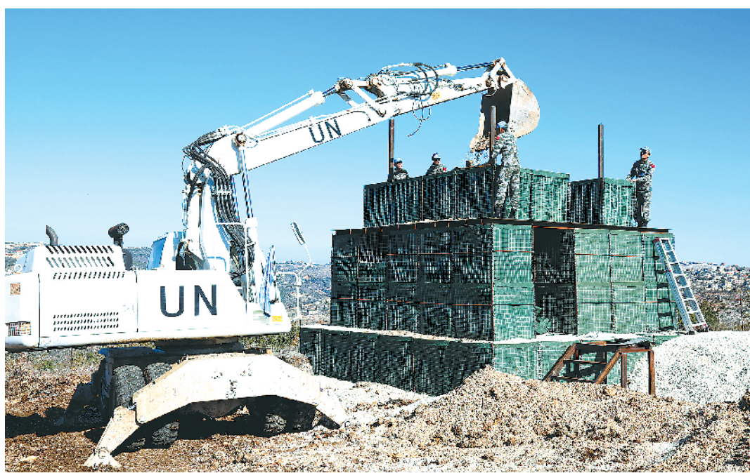
当地时间12月29日,我第18批赴黎巴嫩维和建筑工兵分队出色完成了为加纳营新建观察哨的任务。加纳营工程参谋西蒙在验收工程后说:“这是我在加纳营见过的最好的工程,非常感谢!”
