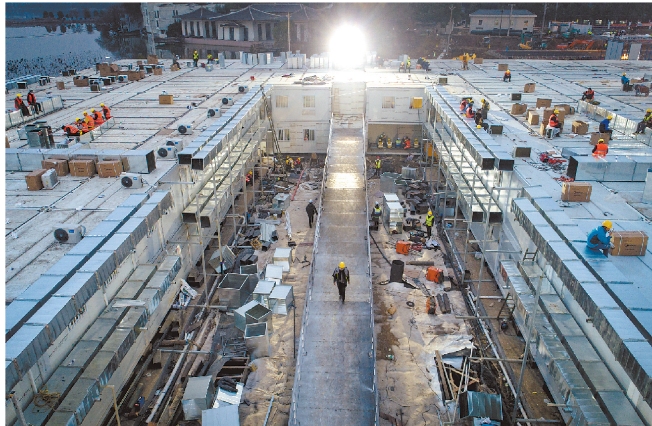
2月1日拍摄的武汉火神山医院建设工地(无人机照片)。
