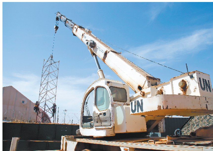
2月18日,应联马团情报部门请求,中国第7批赴马里维和工兵分队官兵在加奥机场建起一座信号塔,这座信号塔的建成将增强联马团的情报收集能力。图为维和官兵吊装信号塔。 本报特约记者 高嵩摄
