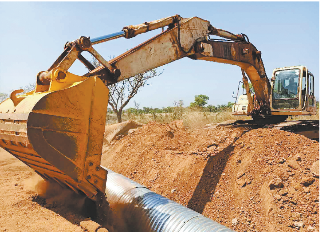
2月26日，中国第10批赴南苏丹维和工兵分队完成科瓦吉纳至马波尔路段一处排水管线修复任务，确保了当地道路通畅。 钱程摄
