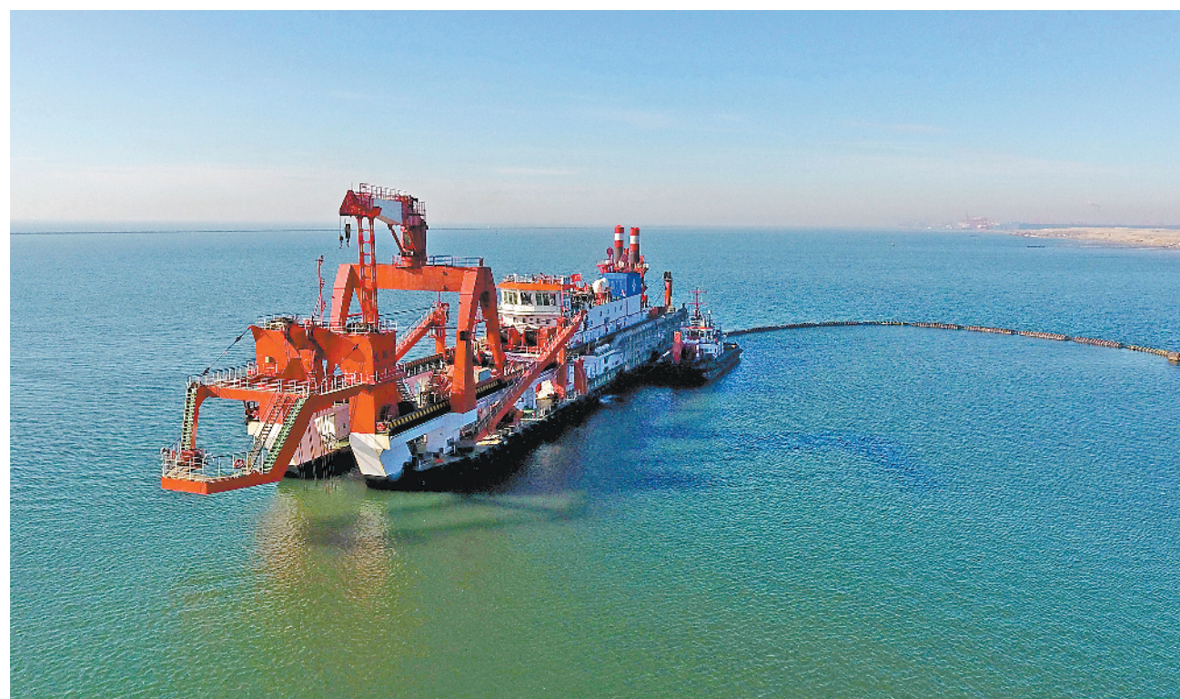
近日，国家交通运输部重点支持项目——唐山港京唐港区25万吨级航道工程复工，全面加快工程进度。图为3月14日，一艘施工船在唐山港京唐港区25万吨级航道工程海域施工作业(无人机拍摄)。
