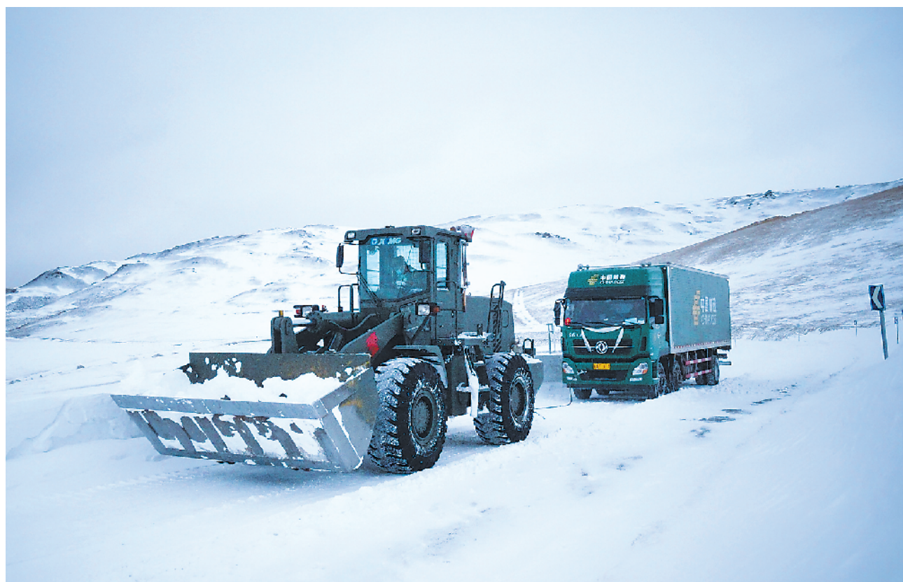
3月13日,西藏阿里地区普降大雪,致使新藏线马攸木拉段过往车辆被困,武警某部交通第三支队官兵紧急出动疏通。经过10余小时努力,道路成功恢复通行。 陆文凯摄
