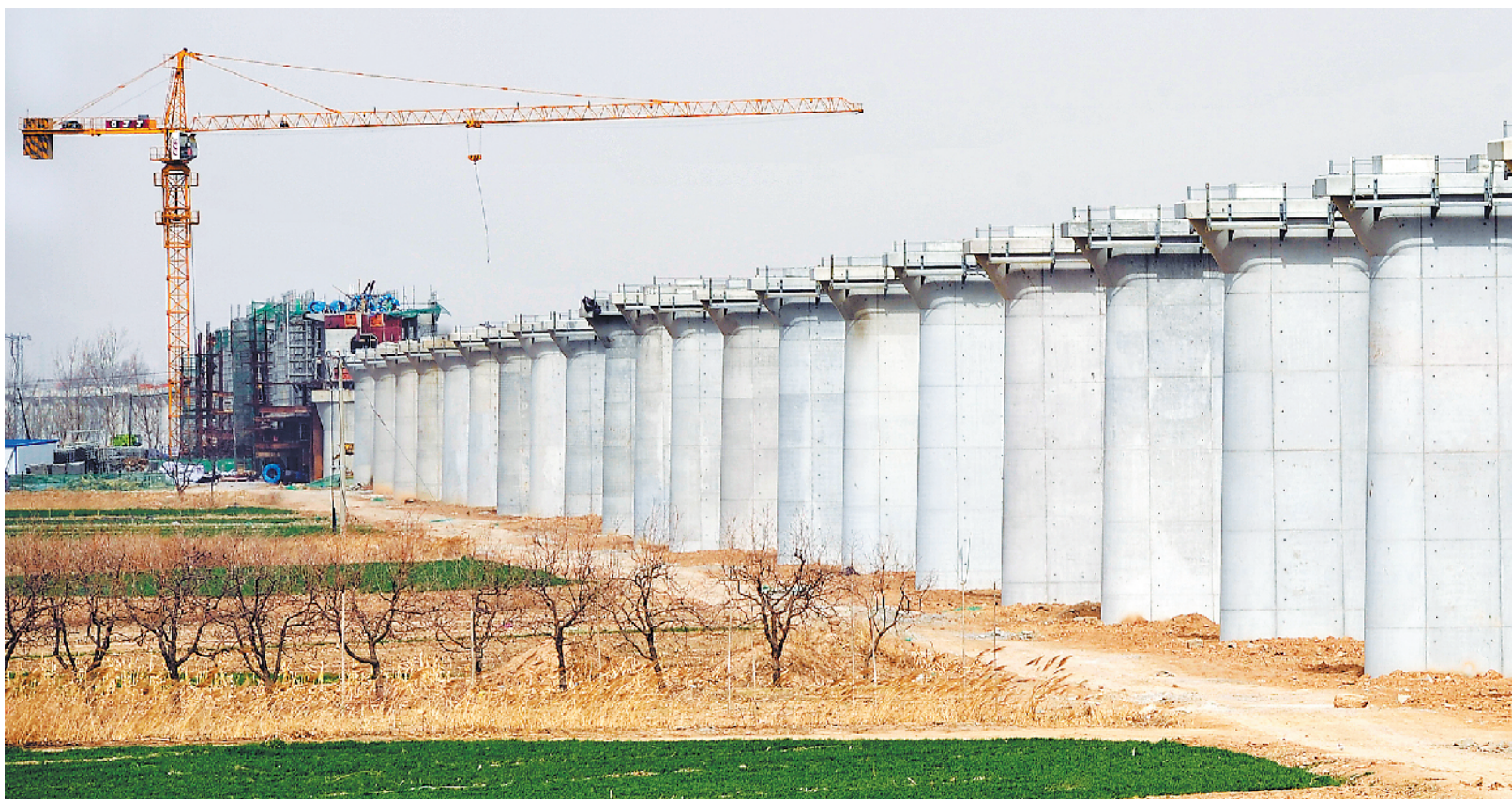
河北省海兴县拍摄的正在施工中的黄大铁路。图为三月二十日在新华社发
