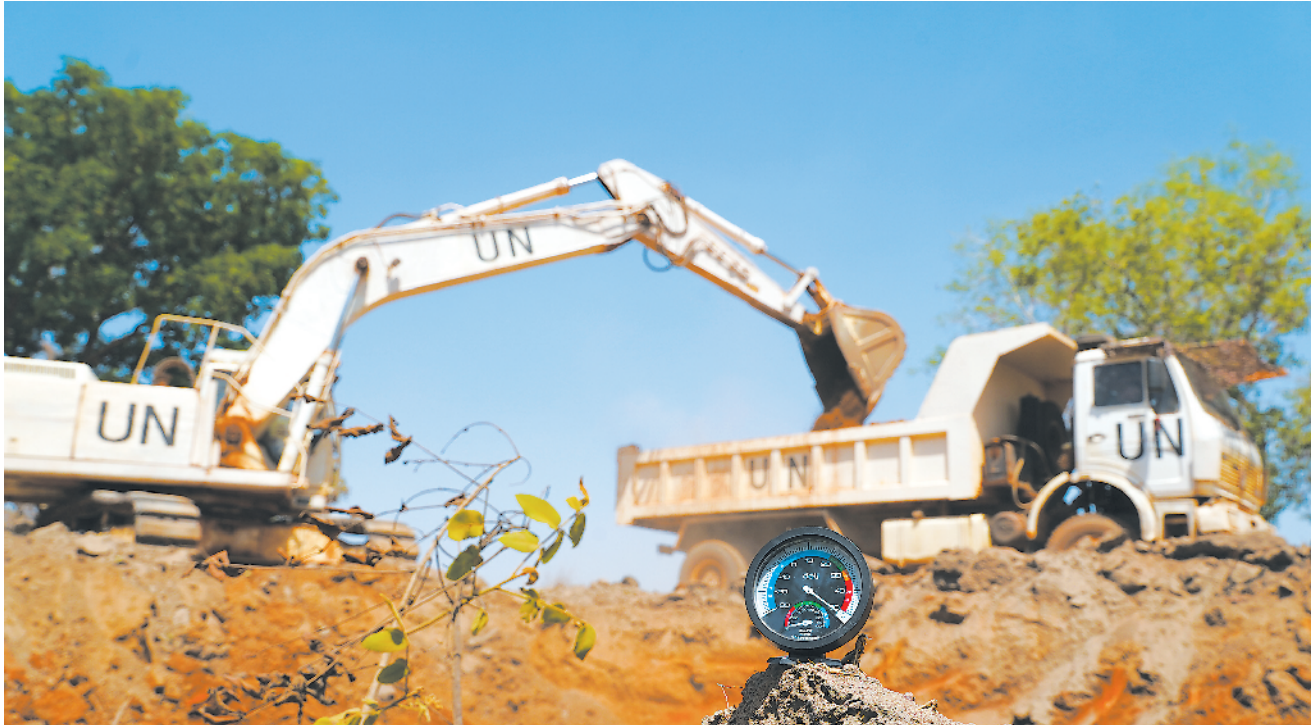
瓦乌一通季补给线,是南苏丹瓦乌市通往首都朱巴的必经道路。由于受恶劣天气影响,以及年久失修,这条补给线损毁严重,极大地影响了联合国物资补给和当地民众生活。受领抢修任务后,我第10批赴南苏丹维和工兵分队在高温环境下克服重重困难,加紧施工。图为我维和官兵在施工中,温度计显示施工地点气温已达50℃。
