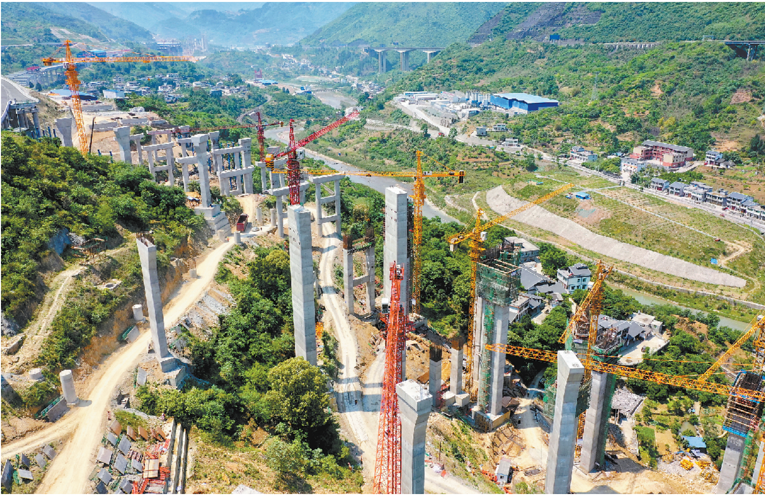
5月2日,建设者在重遵高速(重庆至遵义)扩容工程贵州段紧张施工(无人机照片)。
