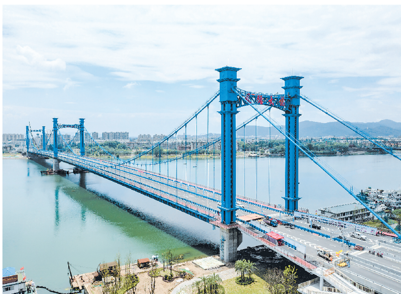
6月24日,由中交二航局投资建设的湖北襄阳风凰大桥正式通车,大桥全长2.6公里,桥面设计为双向六车道,通车后将有助于缓解襄阳市内过江通行压力。新华社发
