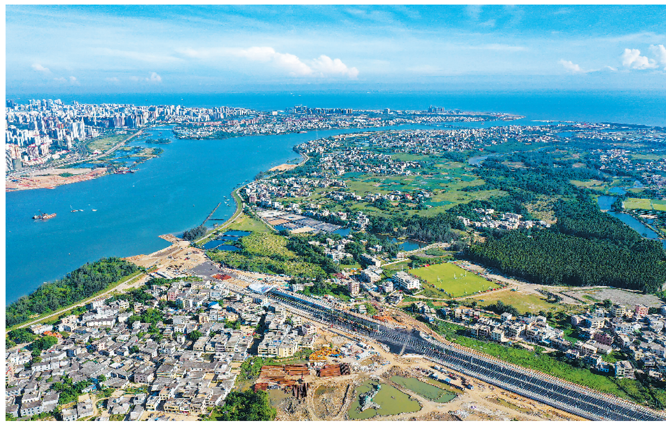
海南自贸港建设全面实施一个月以来,作为自贸港重点园区的海口市江东新区加快项目建设速度,起步区路网、越江通道、哈罗小学等重点项目工地一片繁忙景象。图为位于江东新区的文明东越江通道项目工地(7月2日摄)。新华社发
