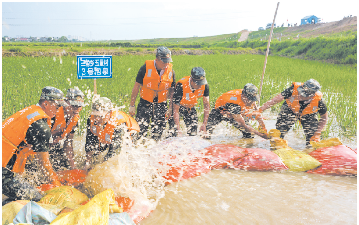
连日来,江西省永修县修河段水位持续上涨,多处圩堤出现泡泉险情,武警九江支队闻令而动,赶赴一线紧急处置。图为官兵在永修县三角联圩搬运沙袋封堵泡泉。
