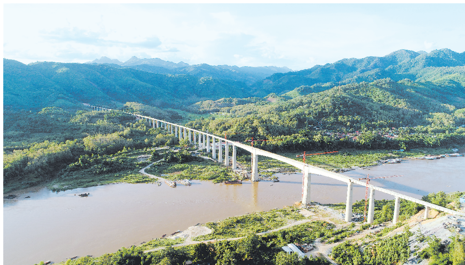
新冠疫情期间,中老铁路班纳汉河特大桥于日前完成架梁施工,中老铁路两座跨河特大桥架梁施工任务全部完成,为中老铁路如期建成通车奠定坚实基础。图为中老铁路班纳汉河特大桥。
