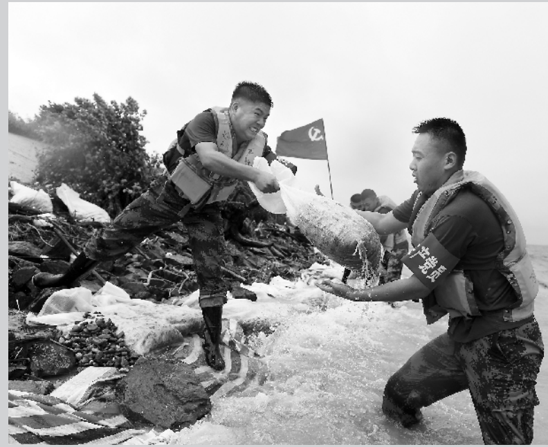
7月20日,江西鄱阳县一处防决堤出现塌方险情,第73集团军某旅合成四营党员突击队临危出击加固堤坝。 朱万福摄
