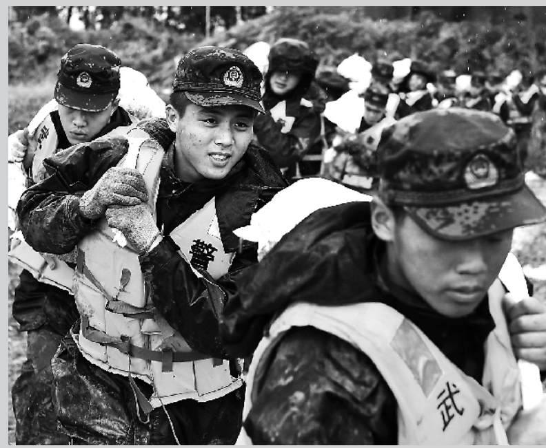
7月16日,长江安徽铜陵段胥坝乡江心洲安平圩出现跌窝险情,武警合肥支队党员突击队紧急驰援,经过8个小时紧张战斗,成功排除险情。 本报特约记者 徐伟摄
