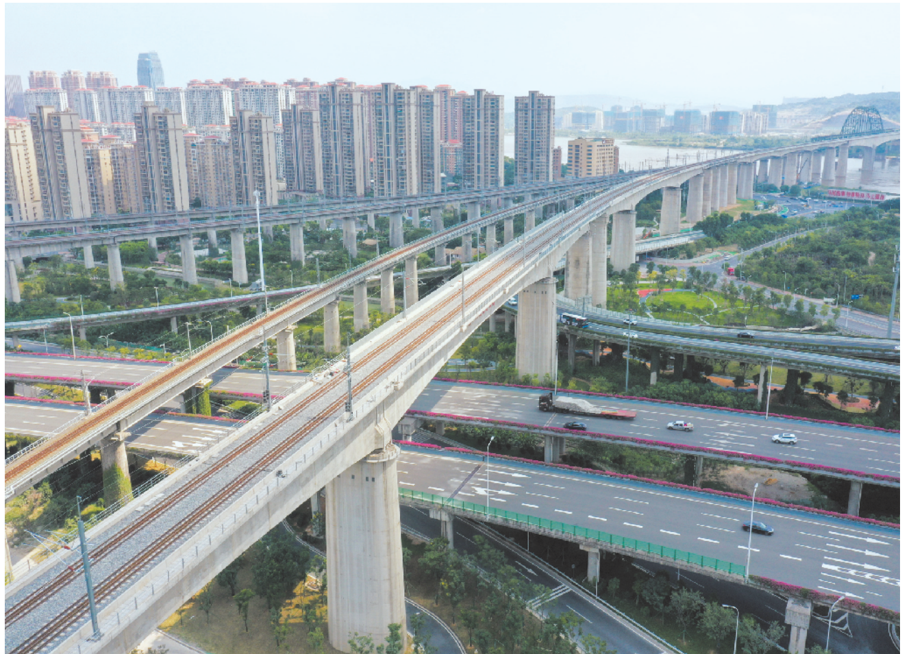
8月24日,中国铁路南昌局集团有限公司福州工务段等线路改作作业人员,在福州至平潭铁路上进行紧张的铁路精调作业。图为正在建设中的福平铁路闽江特大桥。 新华社发
