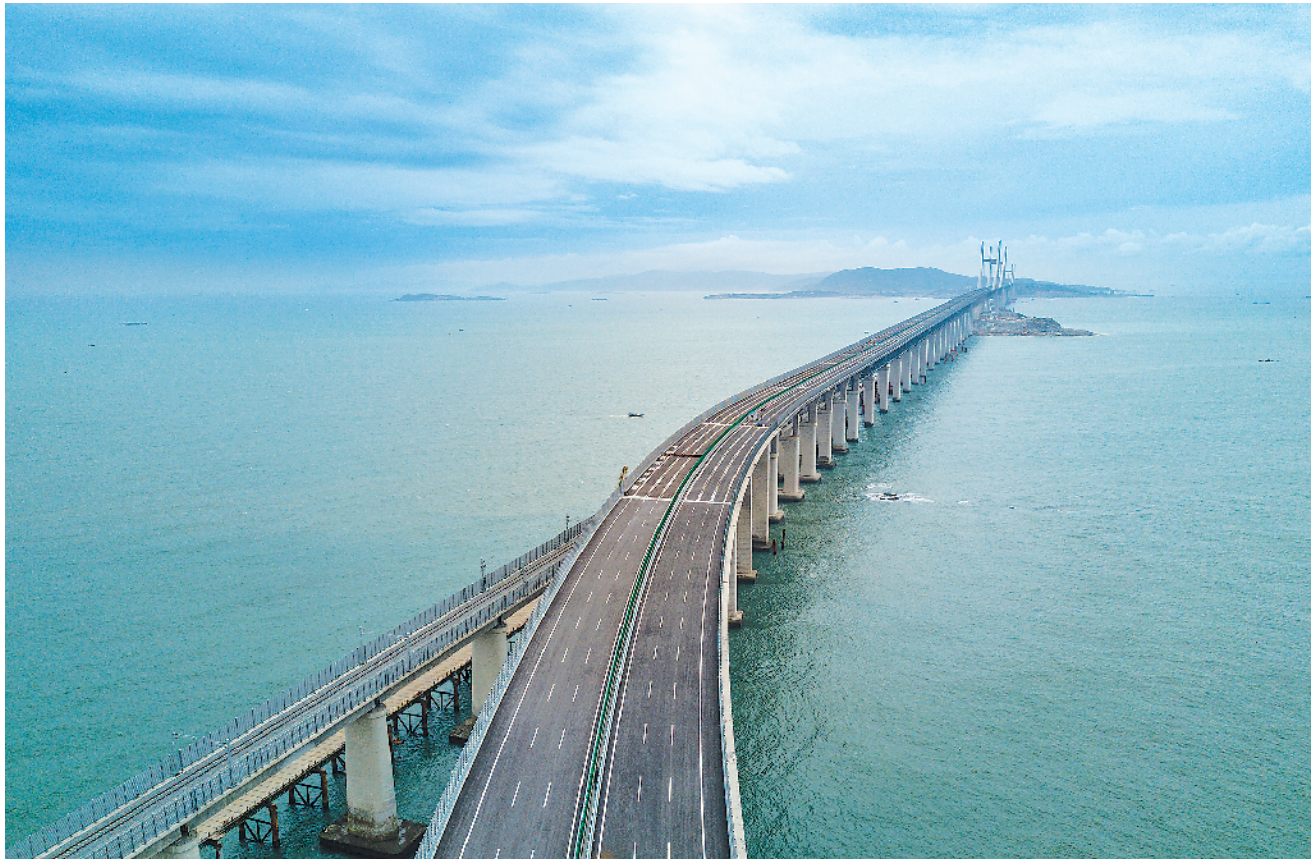
平潭海峡公铁大桥是福州至平潭铁路控制性工程，也是“十三五”规划中北京至台湾高铁的先期工程。按计划，大桥 9 月初将完成静态验收。 新华社发
