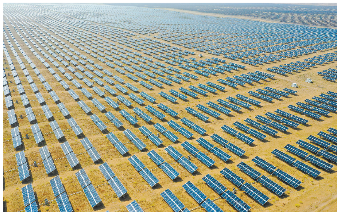
日前，由中建中环工程有限公司承建的内蒙古达拉特旗光伏发电领跑奖励基地1号项目顺利建成完工，该项目建成后与基地内一期光伏电站连成一体。图为9月14日拍摄的位于库布其沙漠中的光伏发电基地(无人机照片)。新华社发
