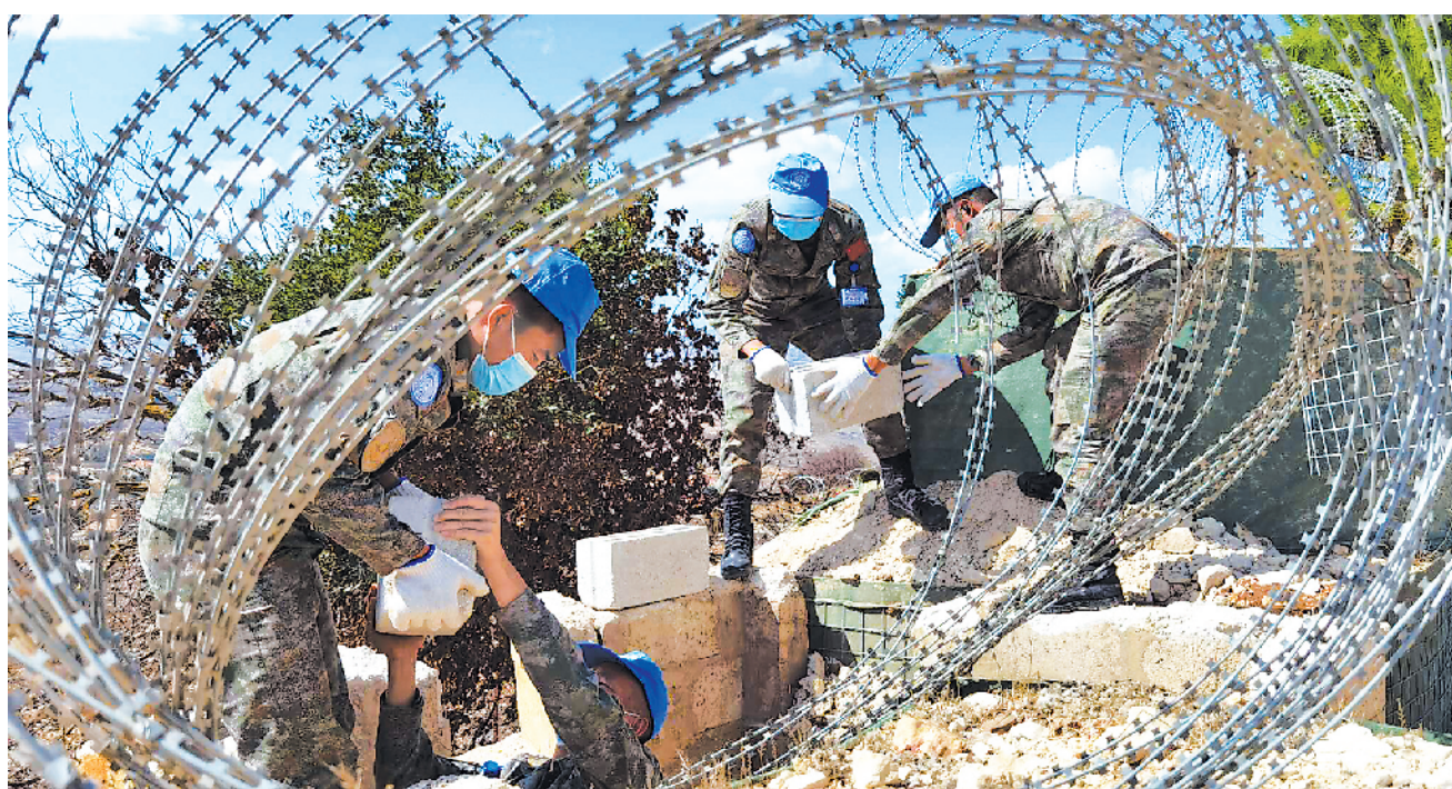
当地时间10月9日,根据联军部队任务安排,中国第19批赴黎巴嫩维和建筑工兵分队完成对尼泊尔营3个营区,包括防卫哨、观察哨和铁丝网防护栏等在内的多个防卫工事的整体检修和翻新,提升了尼泊尔营的安全防卫能力。
