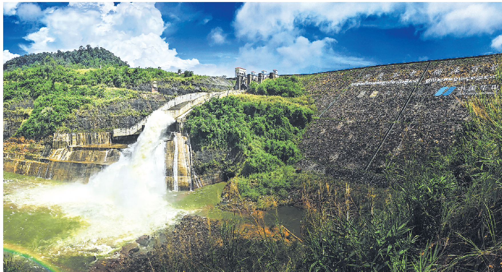
中国华电柬埔寨额勒赛水电站项目位于距离首都金边350公里的戈公省豆蔻山深处,2010年4月2日动工建设,自2013年9月首台机组投产以来已累计发电超67亿千瓦时。据了解,该项目2012年11月注册联合国CDM项目,取得温室气体减排量的国际交易资格,并于2019年完成首笔交易,标志着额勒赛项目在设计清洁发展机制领域取得了新的实质性突破。图为在柬埔寨戈公省拍摄的额勒赛水电站上大坝。
