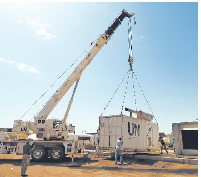
日前，应联马团东战区民事工程处请求，中国第8批赴马维和工兵分队派出吊车作业组，帮助其顺利完成故障发电机更换。中国工兵分队专业、高效的吊装作业能力，受到民事工程处人员的称赞。图为作业现场。
