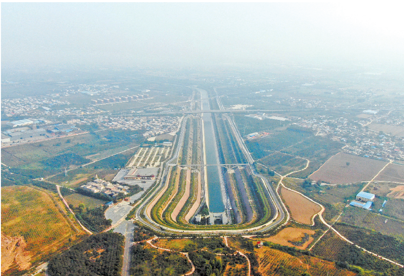
南水北调中线自2014年12月通水以来，供水量持续增长，水质稳定达标，已成为众多沿线城市供水生命线。图为无人机拍摄的南水北调穿黄隧洞进口南岸明渠。
