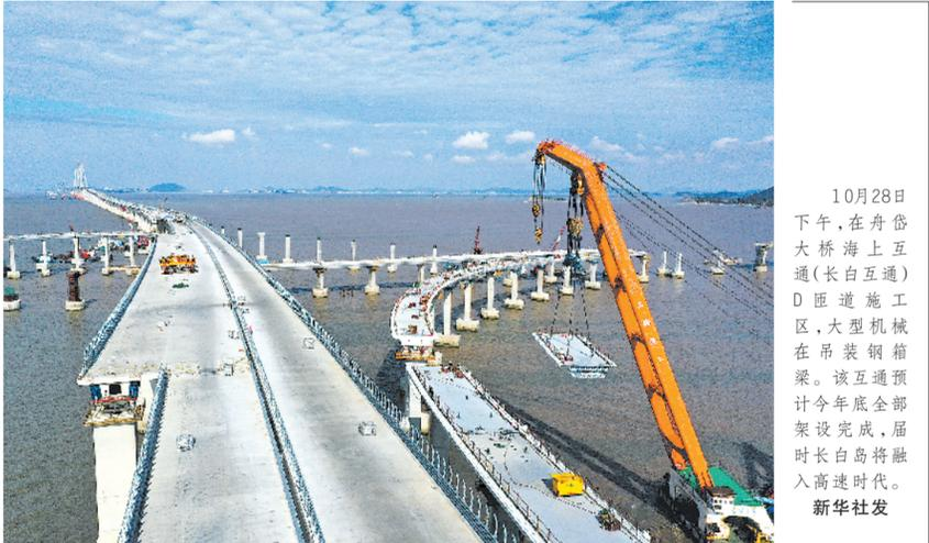
10月28日下午，在舟岱大桥海上互通(长白互通)D匝道施工区，大型机械在吊装钢箱梁。该互通预计今年底全部架设完成，届时长白岛将融入高速时代。新华社发
