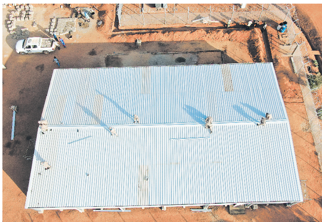
近日，经过连续22天的紧张施工，我第8批赴马里维和工兵分队高标准完成联合国驻东战区前进指挥所建设任务，有效提高了各国维和部队统等指挥和应对安全风险能力。图为我维和官兵在紧张施工。
