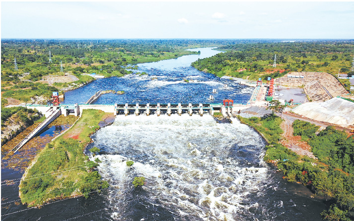
由中国水电承建的卡鲁马水电站是乌干达在建的最大水电站,项目总投资约17亿美元,设计装机容量60万千瓦。目前,项目已经进入收尾阶段,约98%的工程已经完工。图为航拍的卡鲁马水电站。 新华社发
