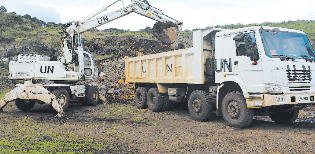
近日,我第24批赴刚果(金)维和工兵分队按照联刚稳定团南战区司令、对南战区司令部2号营区道路进行抢修。我维和官兵严格落实疫情防控规定要求,科学组织施工、冒雨连续作业,按时保质完成道路抢修任务,受到联刚稳定团高度赞扬。图为施工现场。 席海春摄
