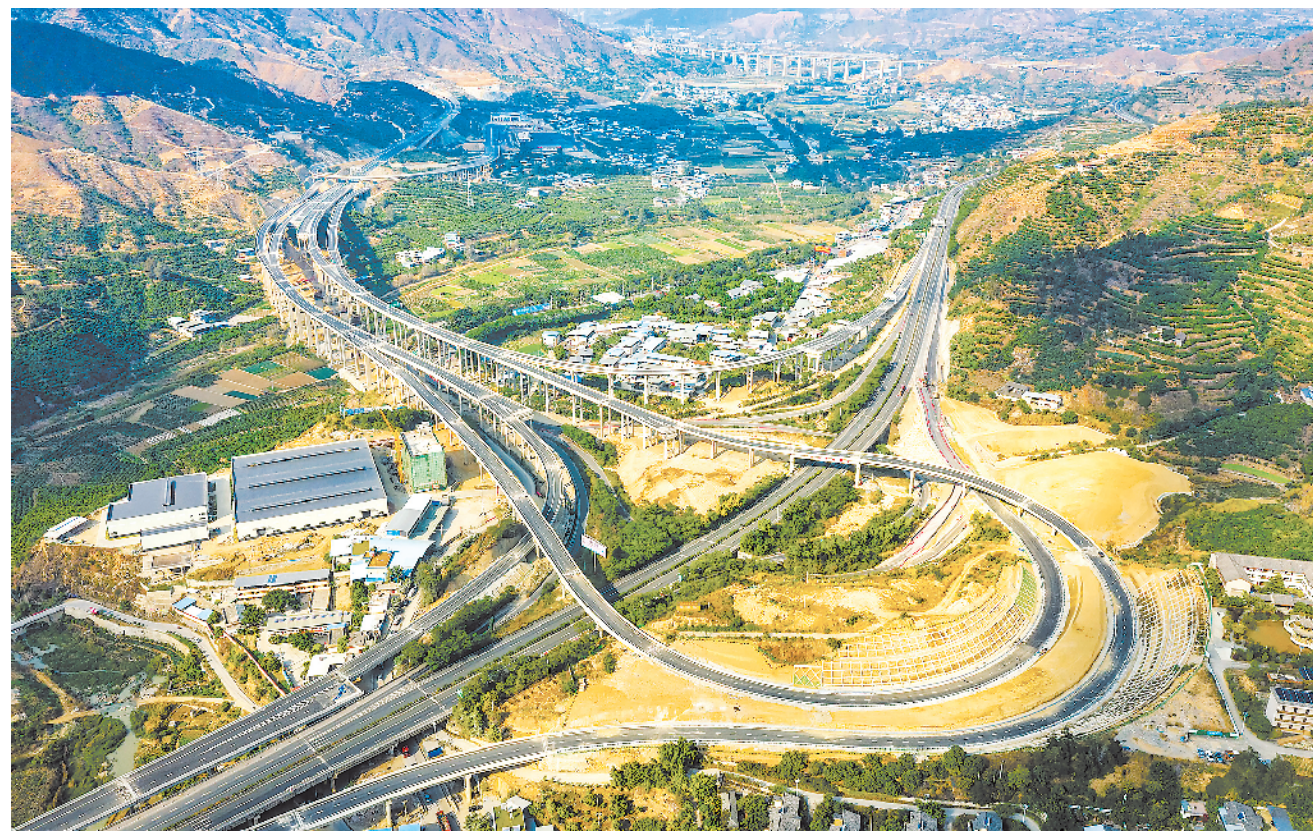
12月6日,全长约41公里的四川攀枝花至云南大理高速公路(四川境)全面建成并试通车。图为攀大高速公路(四川境)总发枢纽互通(12月4日摄,无人机照片)。 新华社发
