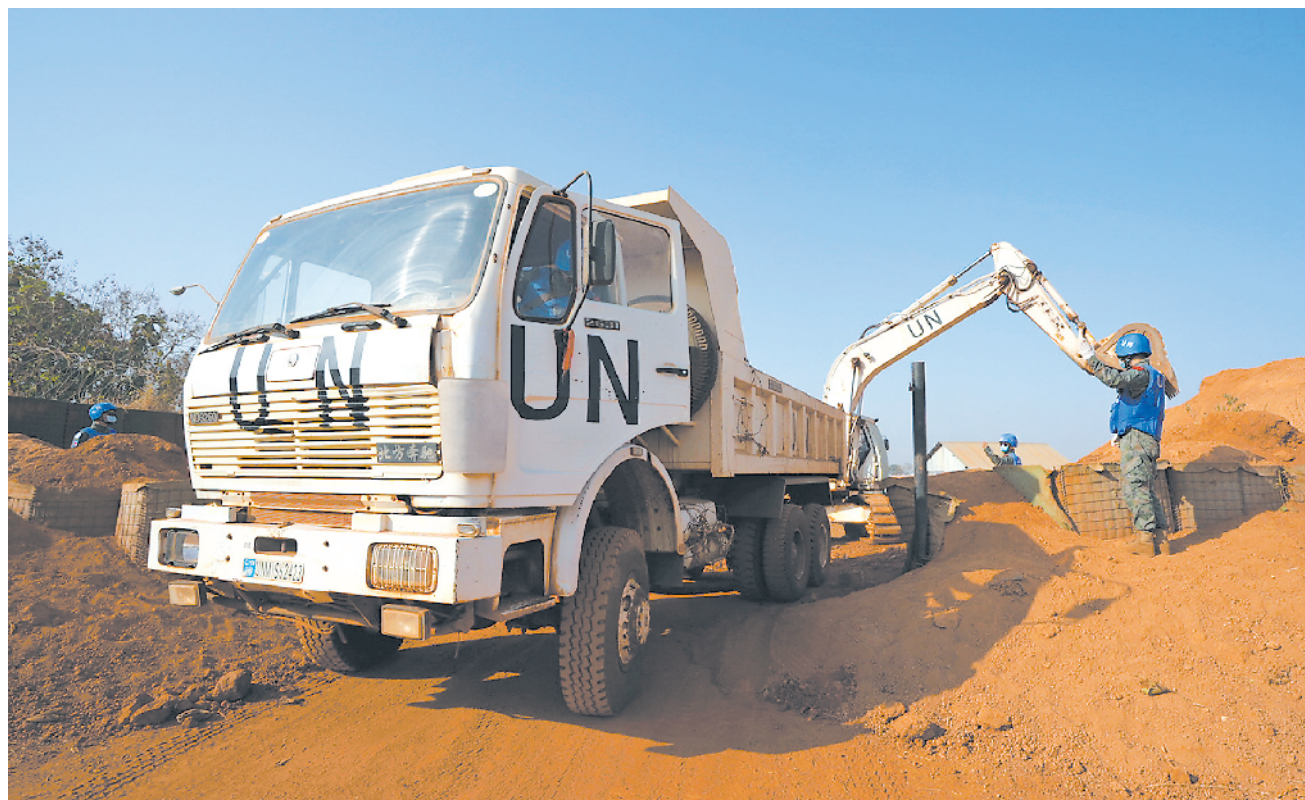
近日,我第11批赴南苏丹(瓦乌)维和工兵分队对超级营地附近损毁道路展开修缮和维护,这是分队抵达任务区后首次执行联合国维和任务。图为当地时间12月9日我维和工兵分队工程车进行取土作业。 韩一民摄
