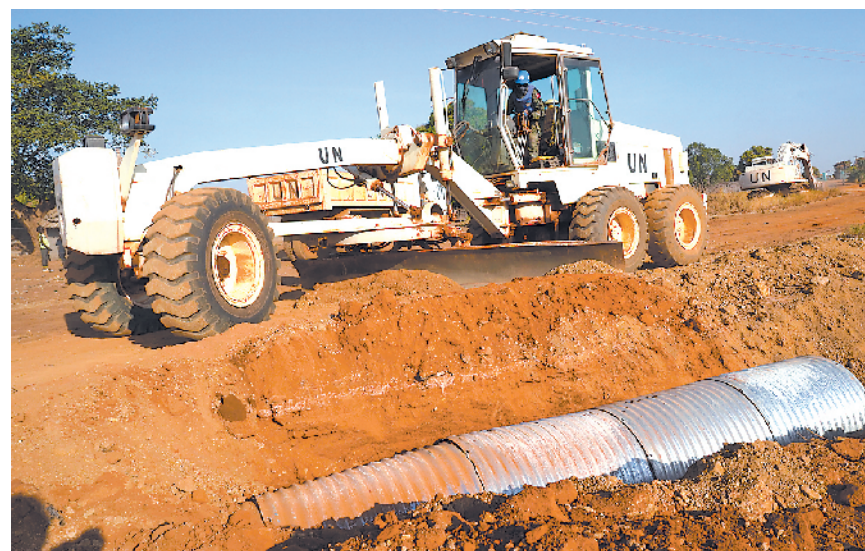
12月18日,我第11批赴南苏丹(瓦乌)维和工兵分队受领联南苏团施工任务,对遭到暴雨损坏的瓦乌市区内部道路和排水系统进行抢修。图为施工现场。
