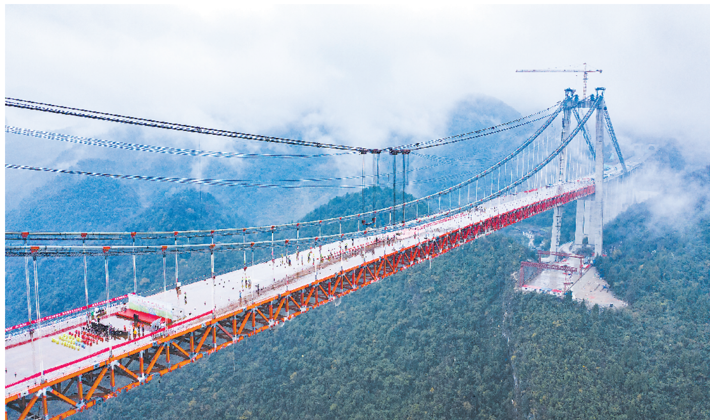
十二月二十九日，随着最后一块桥面板吊装完成，河内渡马江特大桥顺利合龙。新华社发
