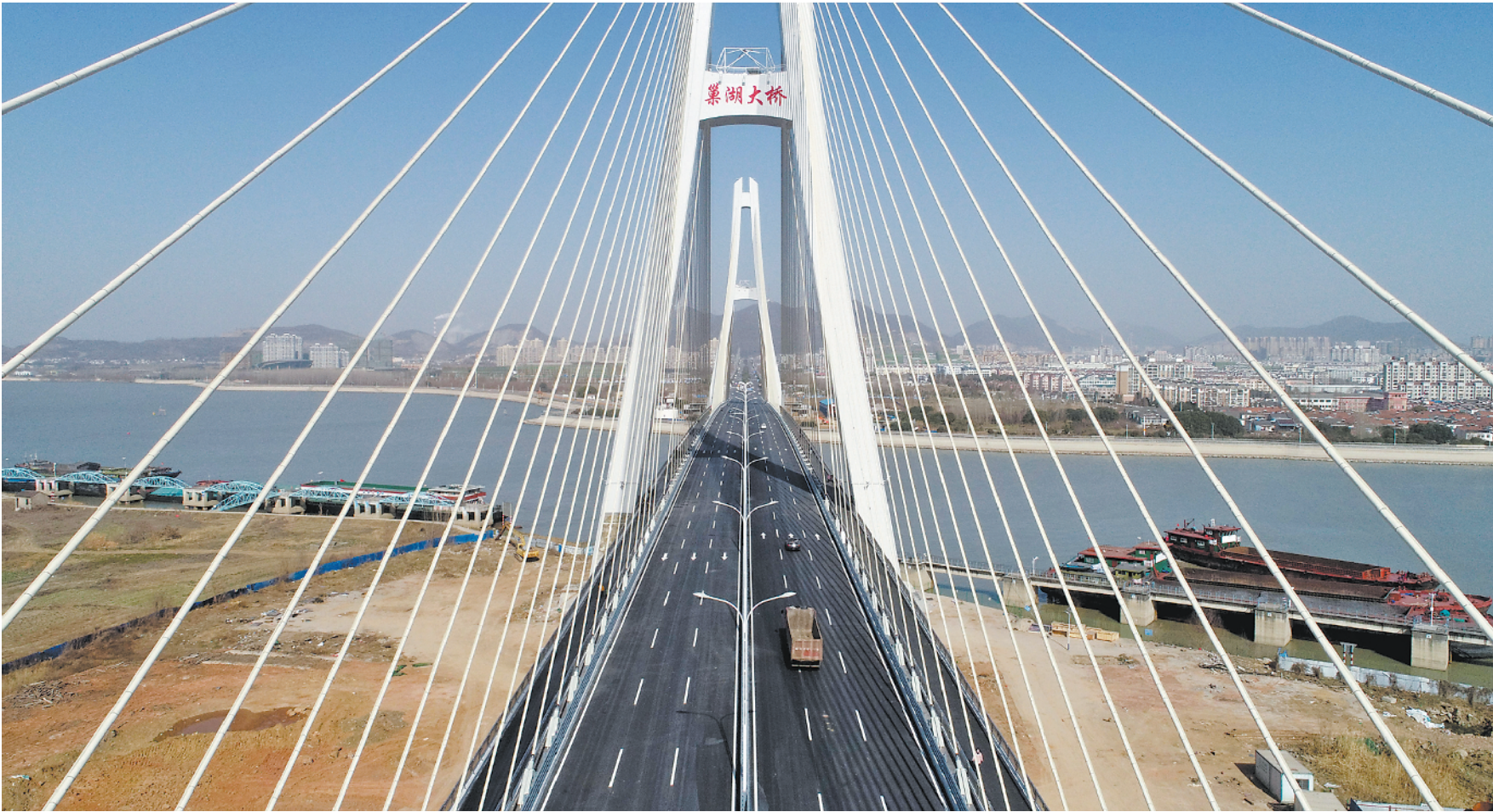
1月12日，车辆行驶在巢湖大桥上(无人机照片)。当日，由中铁建大桥局承建的安徽巢湖大桥建成通车。巢湖大桥设计为全线双向六车道，桥梁长度1122米，于2018年1月12日正式开工建设，是环巢湖大道贯通的重要节点工程之一。 新华社发
