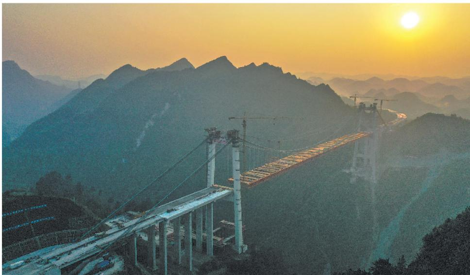
目前,由中交二公局第二工程有限公司承建的贵(阳)黄(平)高速公路阳宝山特大桥建设进展顺利,工程已进入钢桁梁吊装收尾阶段。阳宝山特大桥位于贵州省黔南布依族苗族自治州贵定县新巴镇和德新镇境内,是贵黄高速公路控制性工程。图为3月17日拍摄的夕阳下的阳宝山特大桥(无人机照片)。
