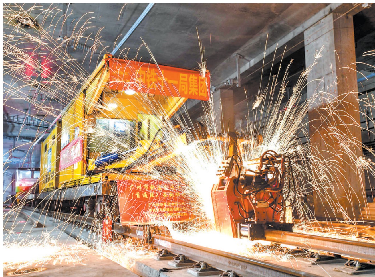
4月20日,中铁十一局轨道焊机在焊接广州地铁18号线首通段最后一个钢轨接头。当日,随着中铁十一局集团三公司施工人员操作轨道焊机位于龙潭至磨沙石区间隧道内的最后一个钢轨接头焊接完成,全长58.3公里的广州地铁18号线首通段(万顷沙至冼村)全线长轨贯通。广州地铁18号线连接广州市中心城区与南沙自贸区,是粤港澳大湾区首条160公里时速的地铁线路。新华社发
