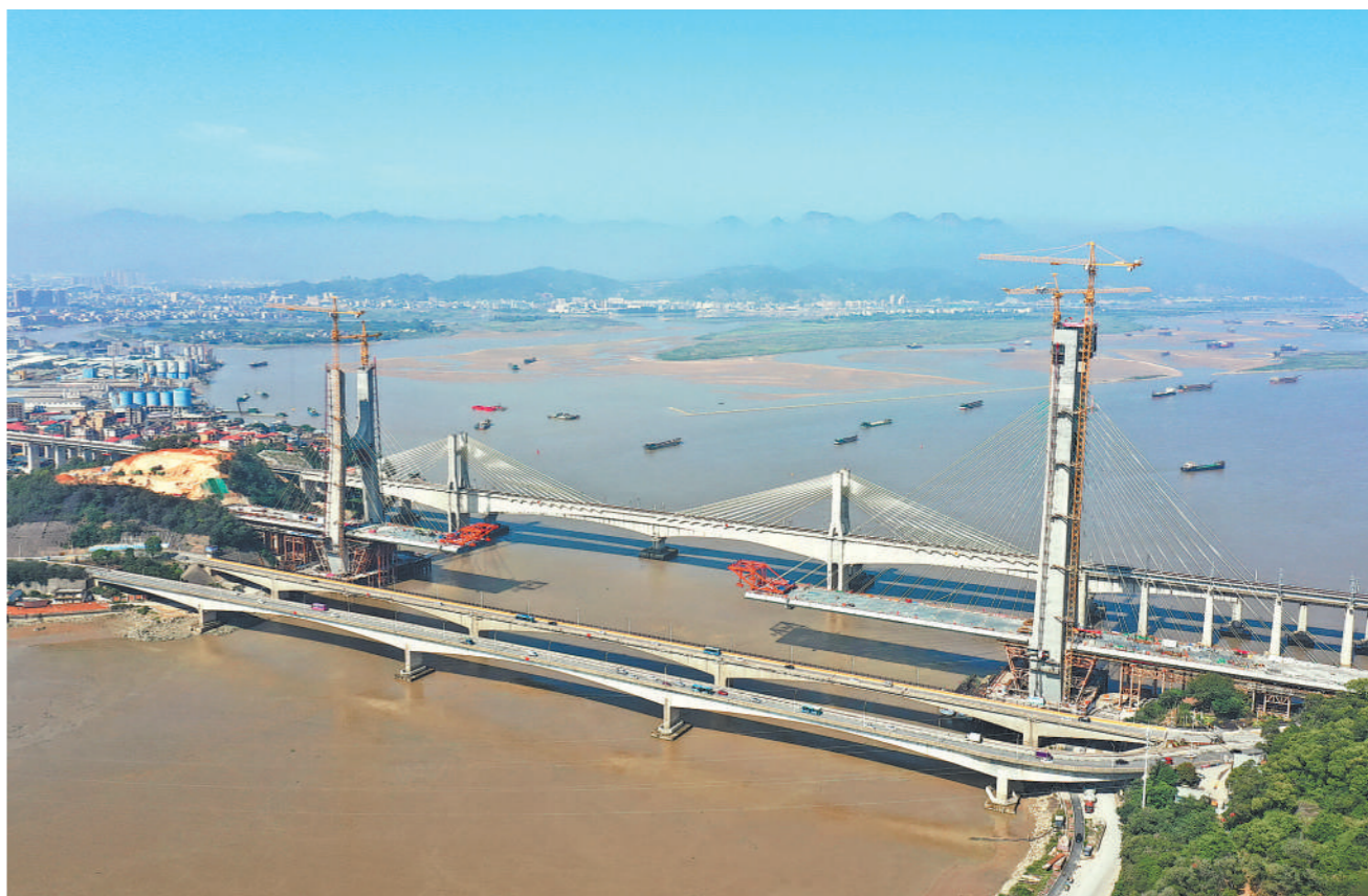
4月30日，由中国中铁大桥局承建的新建福厦铁路乌龙江大桥2号墩主塔顺利完成封顶，标志着大桥建设全面进入胜利合龙的冲刺阶段。新华社发
