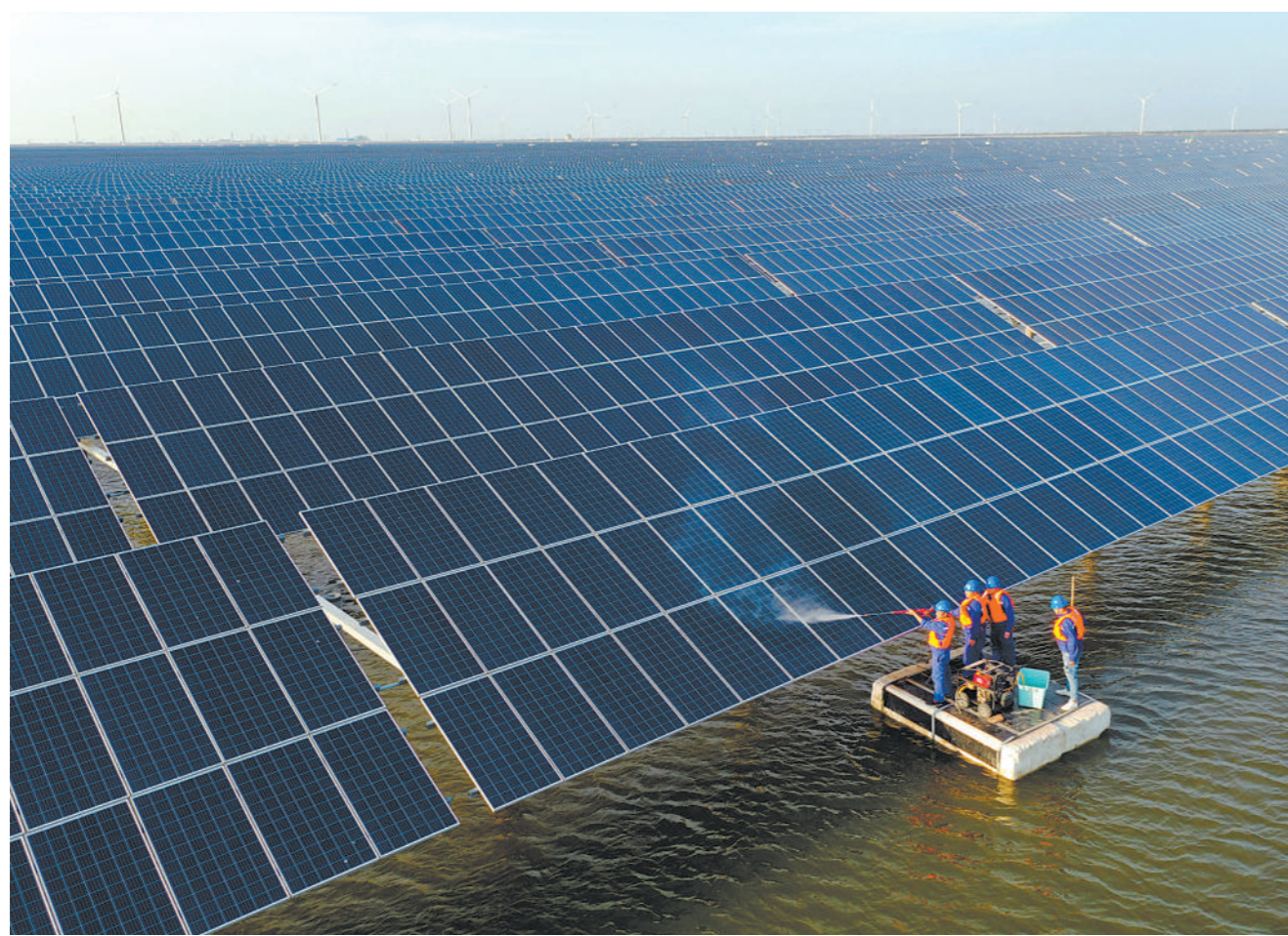
5月18日，工作人员在“渔光一体”海洋牧场清洁太阳能板（无人机照片）。山东省滨州市沾化区通汇30万千瓦“渔光一体”项目占地9000余亩，充分利用立体空间，融合光能、海水等要素，配合风机和盐田，形成了“上光中风下渔盐”的发展模式，实现蓝色产业绿色转型。目前，该项目年可发电4.2亿度，年产“盐田虾”200吨、产值约1400万元。新华社发
