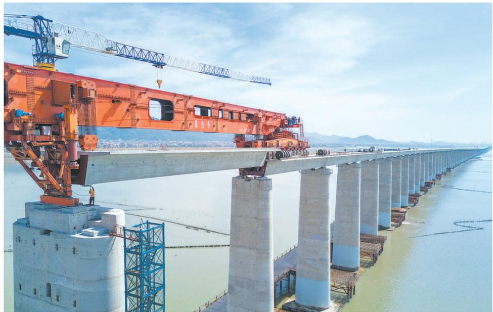
7月11日,我国自主研发的“昆仑号”千吨级运架一体机在中铁十一局承建的新建福厦铁路涠洲湾跨海大桥建设现场,圆满完成最后一孔40米高铁箱梁架梁任务。“昆仑号”是目前世界唯一的千吨级运架一体机,自2020年首次在新建福厦铁路涠洲湾跨海大桥建设现场亮相以来,共架设40米高铁箱梁298孔。
