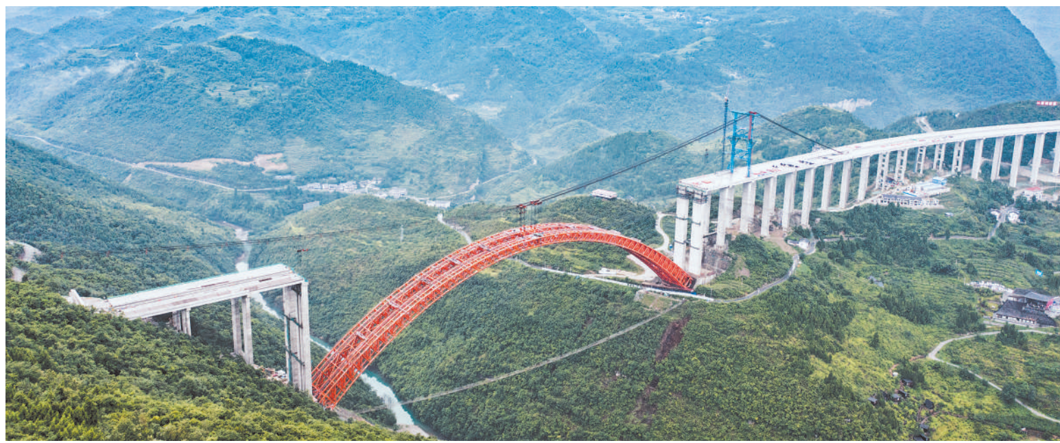
7 月 27 日,贵州仁遵高速大发渠特大桥主拱顺利合龙。大发渠特大桥位于贵州省遵义市播州区和汇川区境内,大桥全长 1427 米、主跨 410 米、桥宽 33 米,是仁遵高速公路的控制性工程之一。 新华社发
