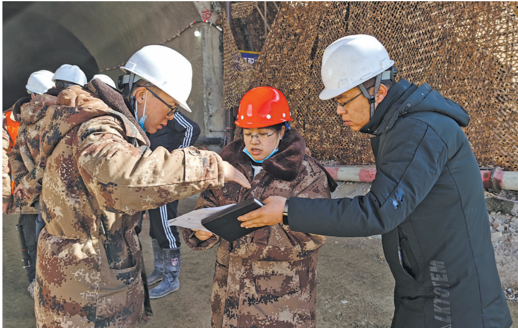
孙海君(右二)在工程现场进行设备验收。 李江华摄
