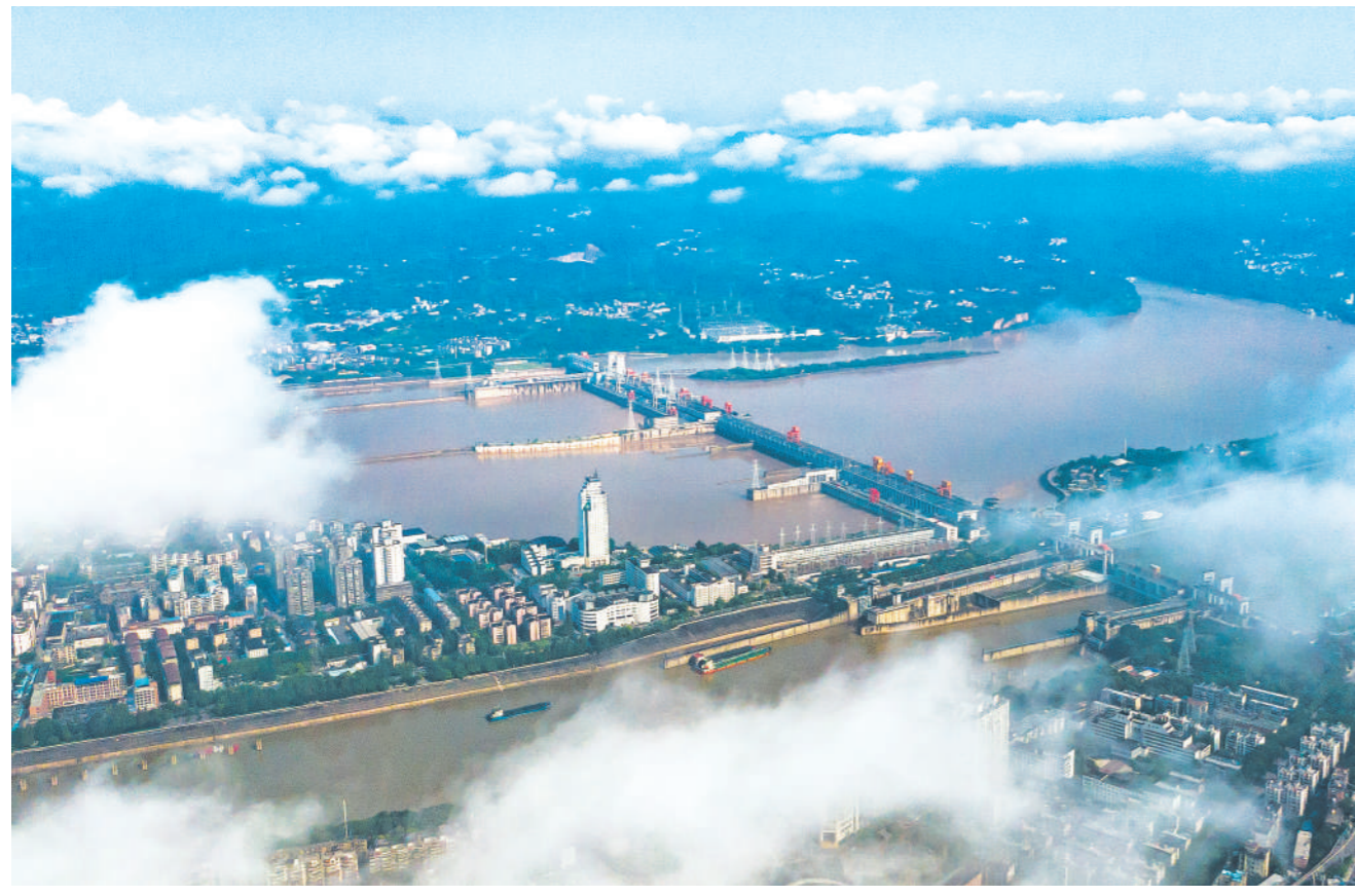
7月29日拍摄的葛洲坝水利枢纽(无人机照片)。被誉为“万里长江第一坝”的葛洲坝水利枢纽，自1981年7月30日首台机组并网发电，为我国社会经济发展注入了强大活力。40年间，这座“万里长江第一坝”为社会累计生产清洁能源近6000亿千瓦时，相当于节约标煤约1.84亿吨，减排二氧化碳5.03亿吨。
