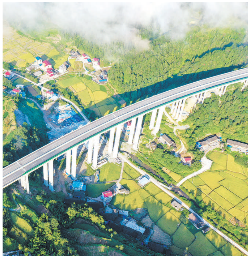
这是9月9日拍摄的石(阡)玉(屏)高速公路(无人机照片)。当日，贵州省石(阡)玉(屏)高速公路正式开通运营。 新华社发
