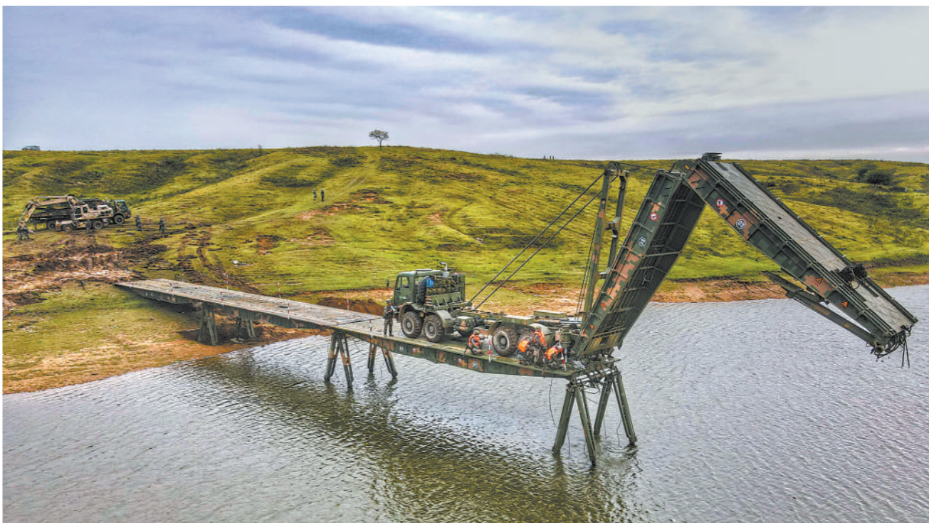
10月中旬,东部战区陆军某工兵旅组织重型机械化桥梁架训练。
