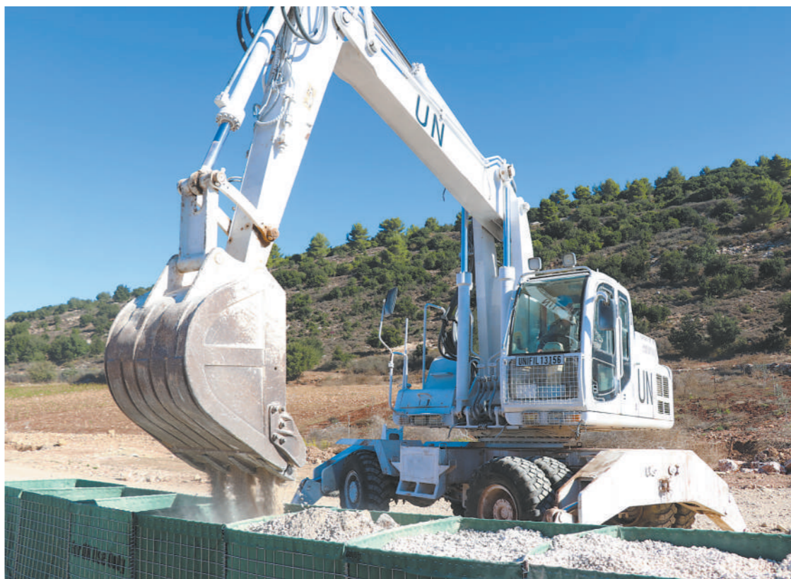
11月8日，中国第2批赴黎巴嫩维和建筑工兵分队，顺利完成黎黎部队一处营地的防御设施修缮升级任务，受到维和友军的高度评价。图为该工兵分队官兵正在施工作业。庄小好摄
