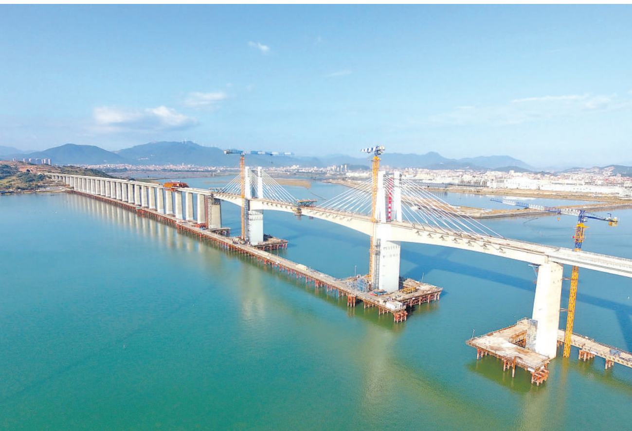
图为11月13日拍摄的建设中的新建福州铁路福州湾跨海大桥。当日，由中铁十一局承建的新建福州(厦)门铁路福州湾跨海大桥成功合龙，标志着新建福州铁路关键控制性节点顺利打通，为如期建成通车打下坚实基础。新建福州铁路福州湾跨海大桥长14.7公里，海城施工长10.8公里，主桥为主跨180米的矮塔斜拉桥，是国内首座跨海高铁矮塔斜拉桥。
