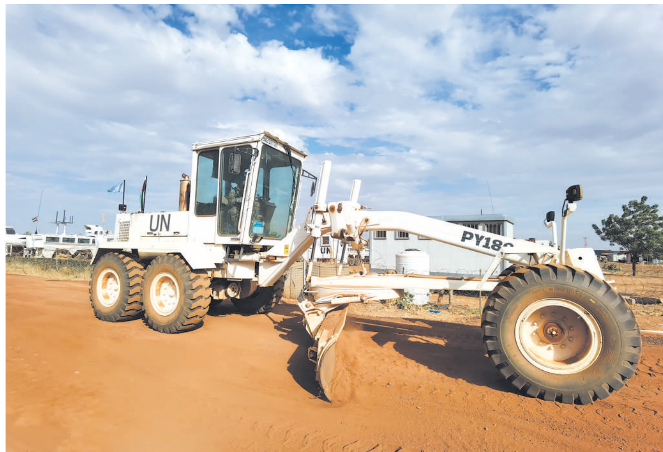
图为我维和官兵驾驶平路机进行场地平整作业。 王兴刚摄
