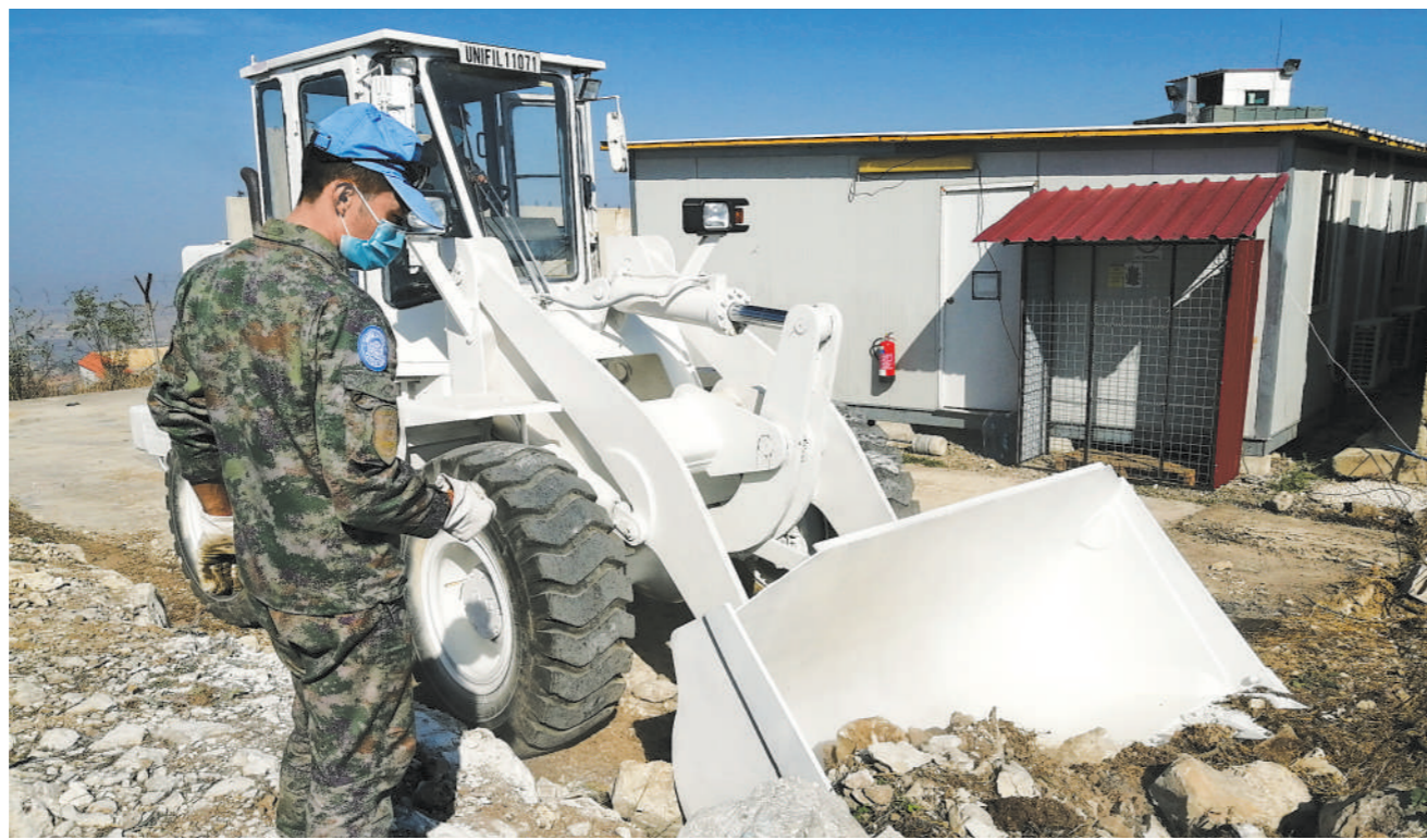
经过连续奋战，中国第20批赴黎维和多功能工兵分队近日出色完成黎黎部队友军营区军事防护围栏网的架设任务。图为维和官兵在施工中。
