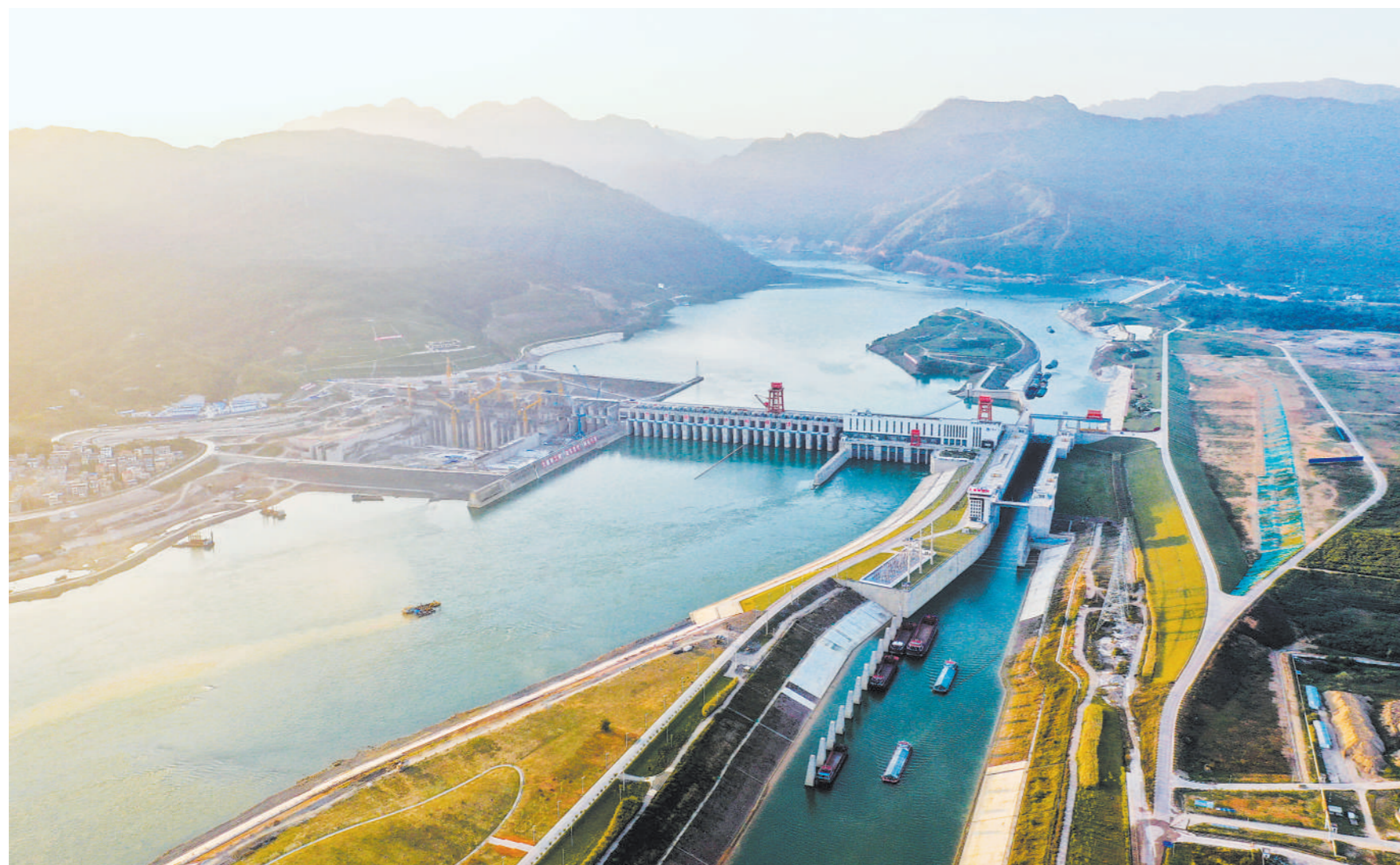
建设中的大藤峡水利枢纽工程位于广西桂平市西江流域上的黔江河段，是国务院确定的172项节水供水重大水利工程之一。图为建设中的广西大藤峡水利枢纽工程(11月26日摄)。
