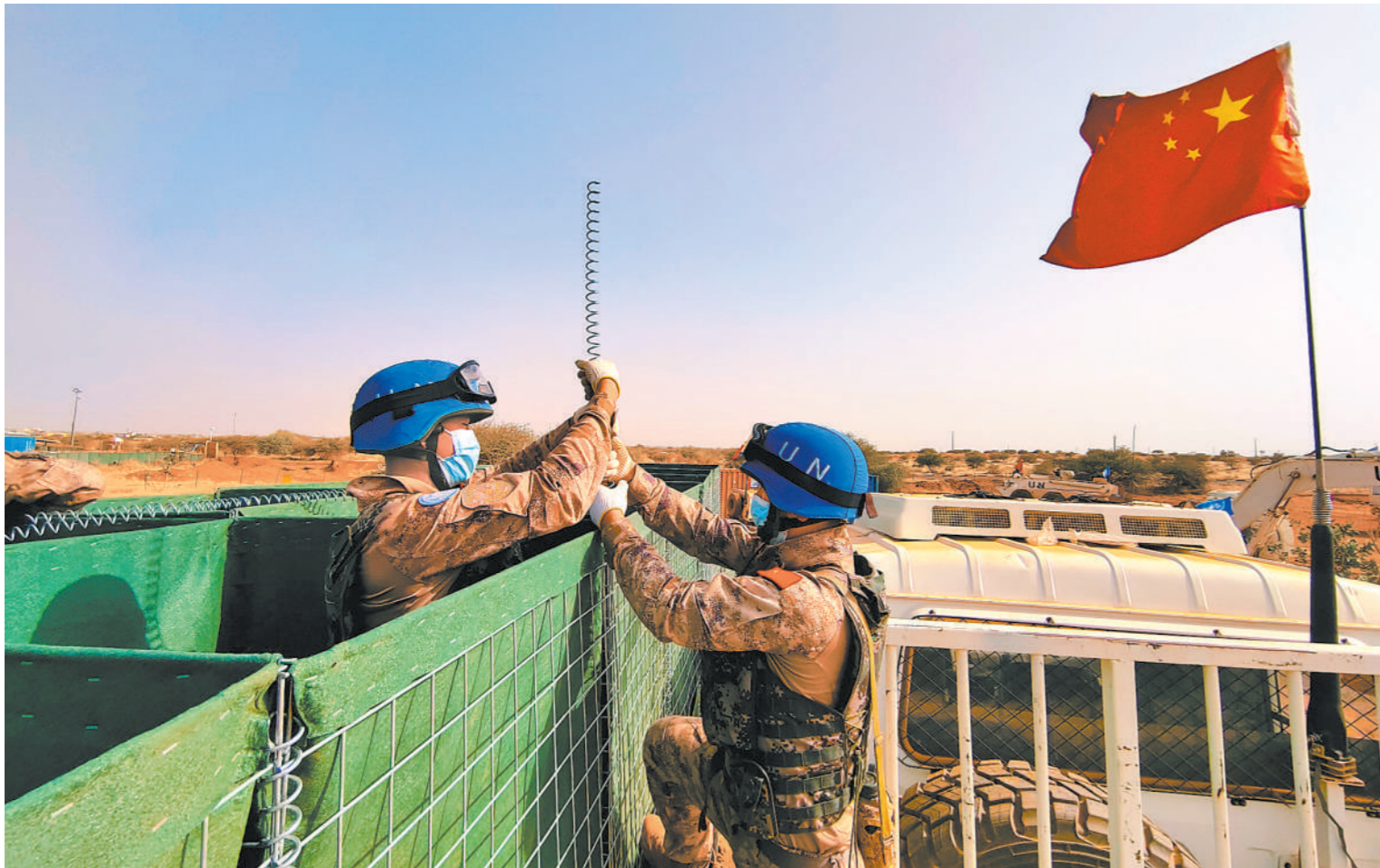
近日,中国第9批赴马里维和工兵分队高质量完成联合国加奥超营北门靶场防御设施修建任务,有效提升了营区整体安防能力。 王宏阳摄
