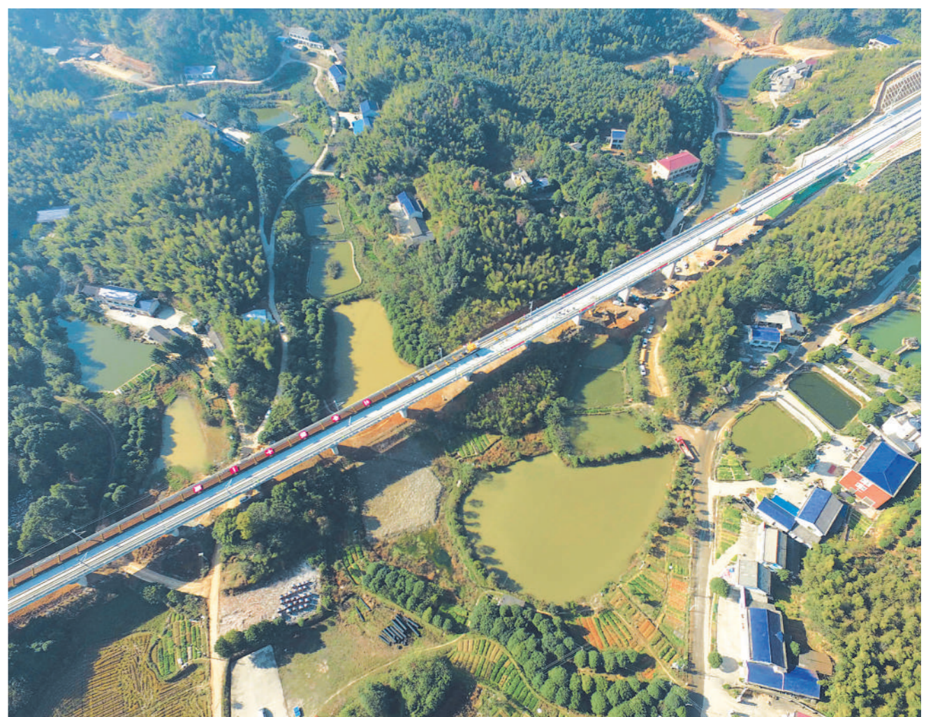
12月1日，湖南省长沙市望城区常益长高铁黄桥大道特大桥施工现场，施工人员在无缝钢轨精准铺设在无缝轨道板上，标志着常益长高铁建设开始进入关键的轨道铺设阶段。新华社发
