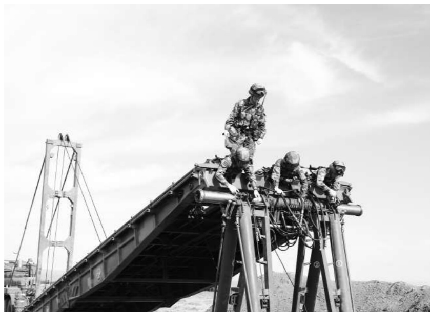
第80集团军某旅工兵连桥梁班正在进行架桥作业。
